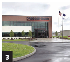
3 Siemens Dresser Rand Division
